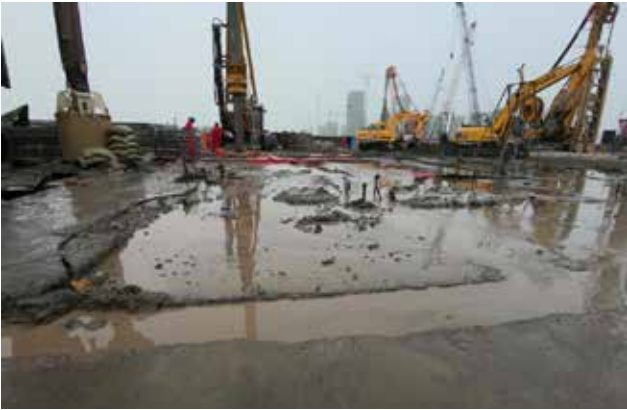
图2 回填碎石与注浆结合现场图
