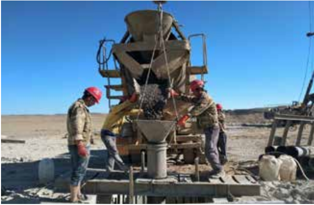
图3 回填C10混凝土现场图
