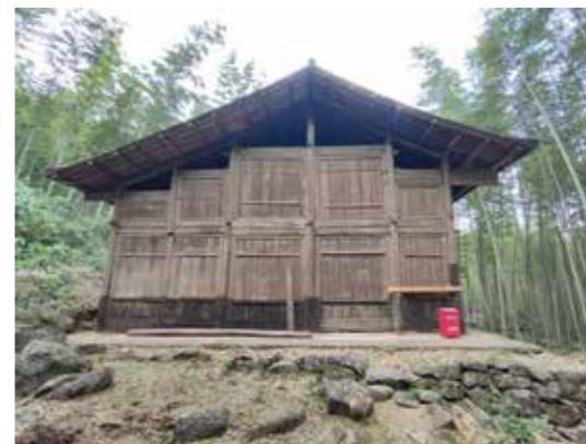
桂北水构建筑的不对称坡屋顶
