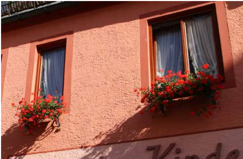
毛面砂浆表面喷涂料后的外观
