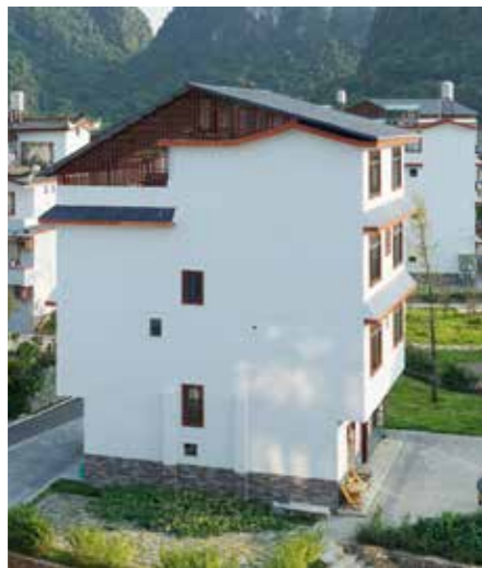
坡面一陡一缓且檐高不等
