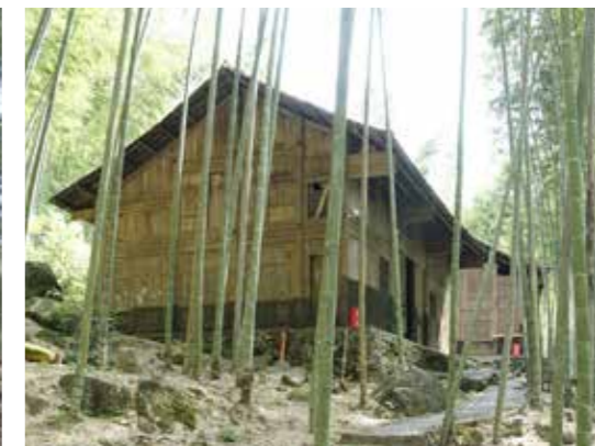
桂北水构建筑的不对称坡屋顶
