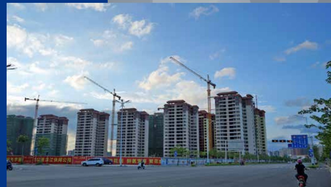
裕达天悦城·明珠花园1#、2#、3#楼及地下室工程项目（荣获来宾市2021年上半年建设工程优质结构奖）
